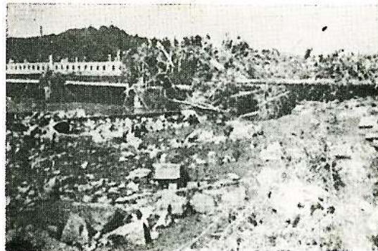
【アイオン台風被害 磐井橋山目側】
